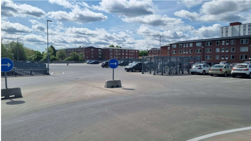
Bild 10. Övre parkeringsdäck i fristående parkeringshus.
