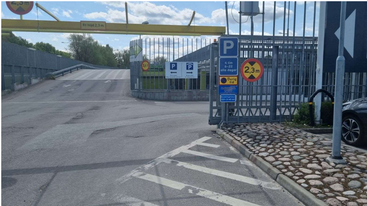
Bild 8. Infart fristående parkeringsgarage
